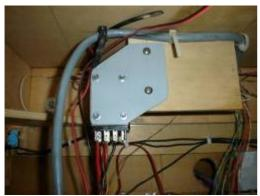
09 Fixation du relais, peut encore 10 La tige traverse la paroi. être réglé.
